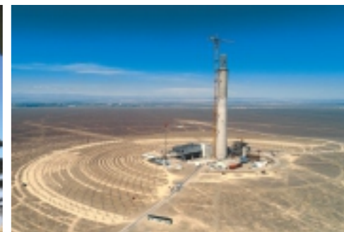
▶ 新疆哈密熔盐塔式5万千瓦光热发电
