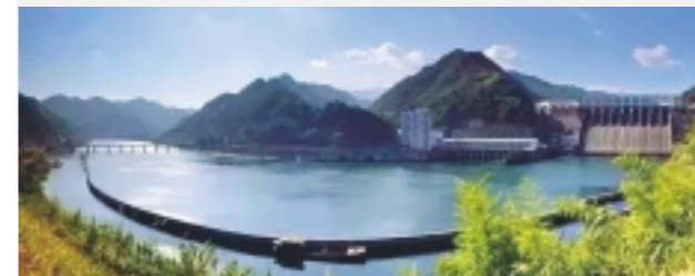
湖南柘溪水电厂外景全貌
